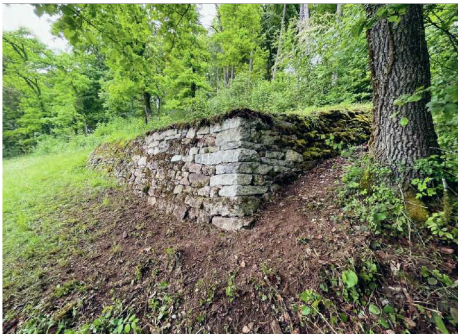
Frisch sanierte Trockensteinmauer im Reservat.
